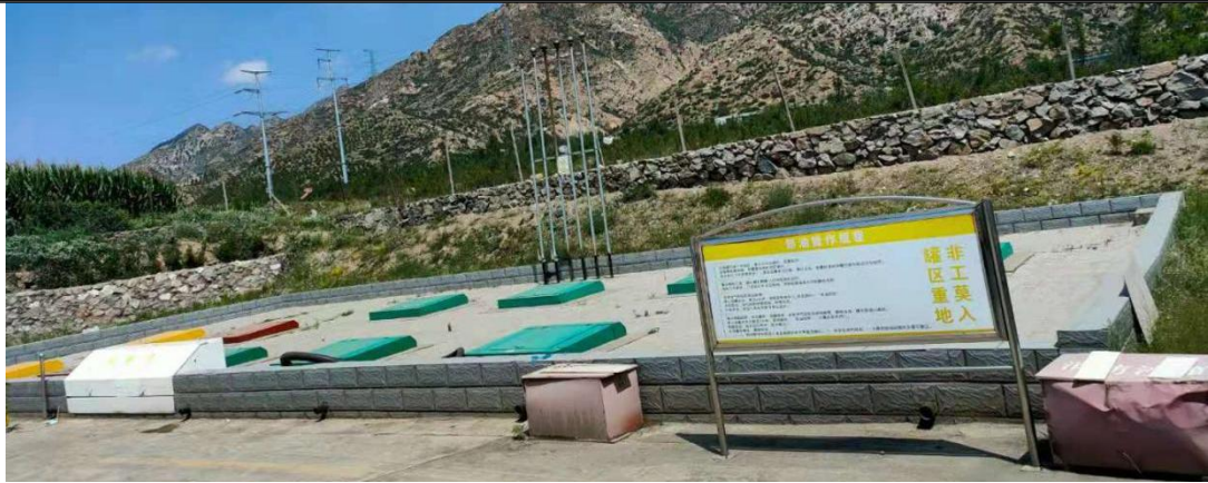
图 3-2 地下油罐储存区
