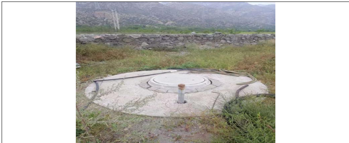
图 3-11 地下水监测井
