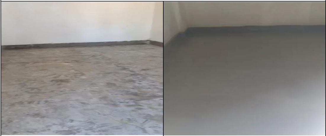
图 3-16 危废间施工图片
