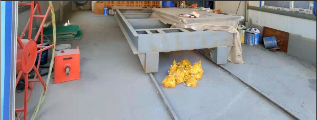
图 3-15 喷漆房施工图片
