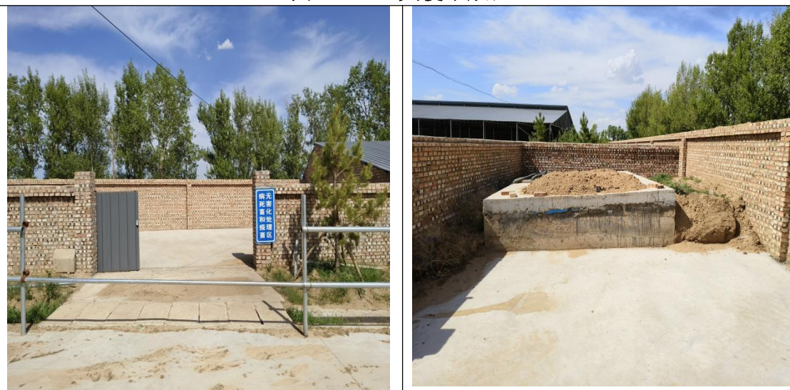
4-10 病死畜无害化处理区
