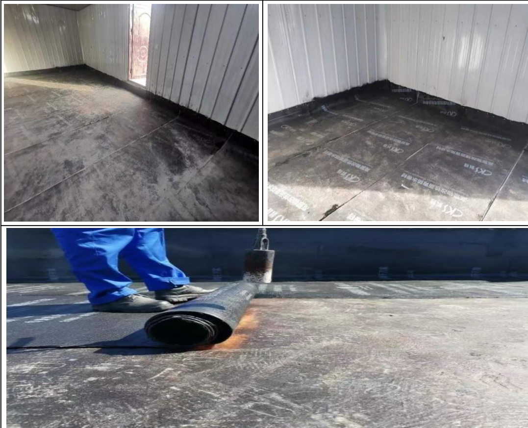
图 3-11 项目防渗施工照片
